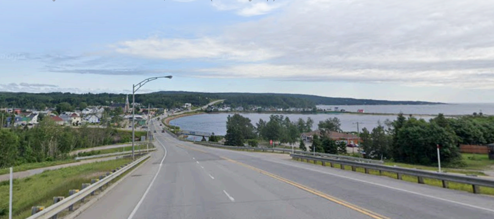
Figure 239 : Vue de la baie des Escoumins, Les Escoumins (Source : Google Maps).
