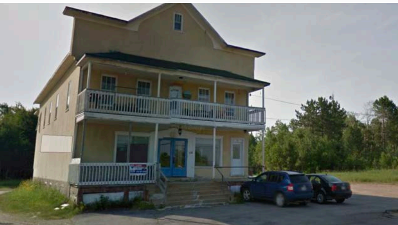
Figure 114 : Ancien magasin général Hovington (vers 1930), 526 rue Principale, Colombier (Source : Google Maps).
