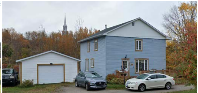
Poste de télégraphie (1900) 217 rue du Bassin
