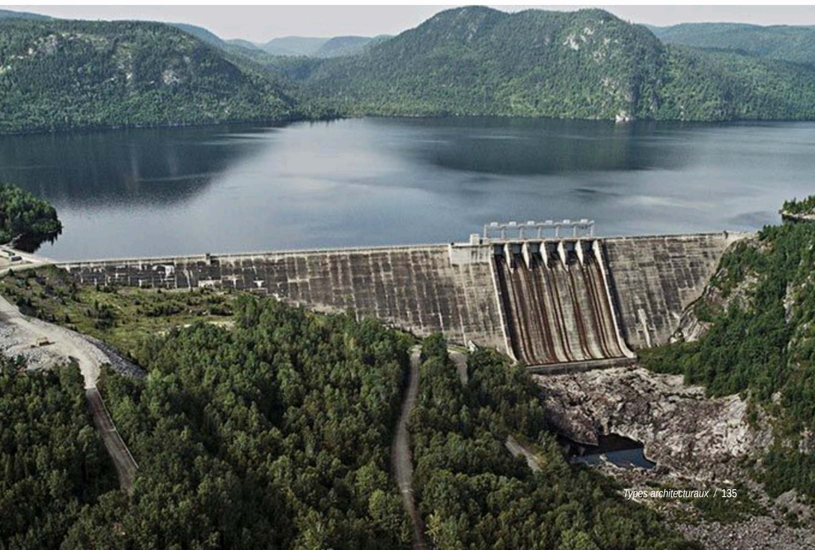
Figure 157 : Vue actuelle du barrage Bersimis-1 (1956), TNO Lac-au-Brochet (Source : Hydro-Québec).
