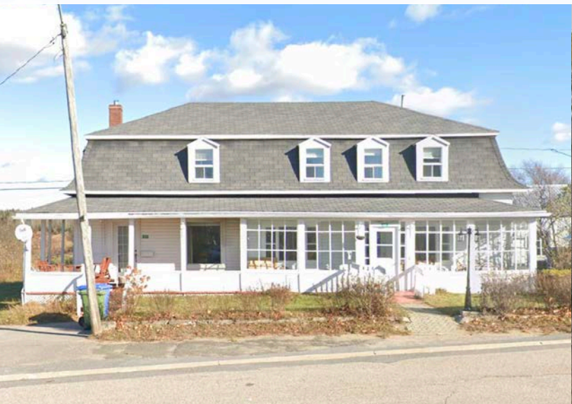
Figure 30 : Maison à toiture mansardée à quatre versants (1900), 49 rue Principale, Les Bergeronnes (Source : Google Maps).
