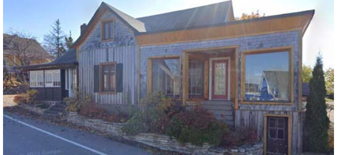
Magasin général Louis Brisson (1900) 50 rue Principale
