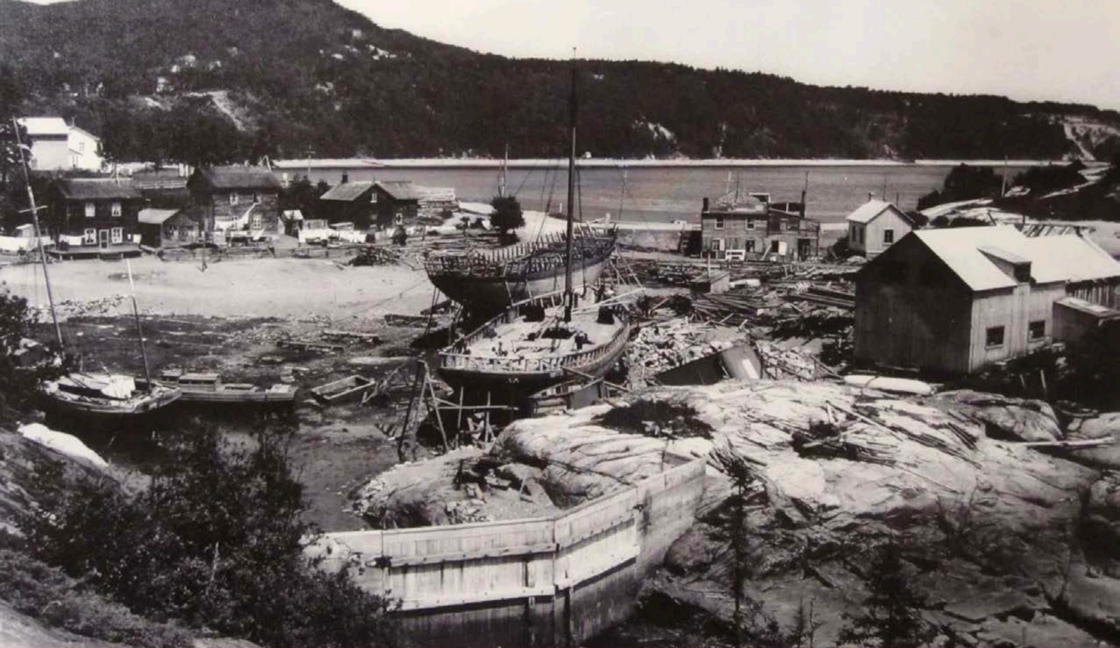
Figure 195 : Goélettes en construction ou en réparation sur le site de la cale sèche, Tadoussac (Source : Tidesoftadoussac.com).
