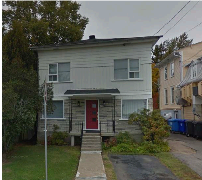
Figure 68 : Maison des bedeaux (1910), 235 rue des Pionniers, Tadoussac (Source : Google Maps).
