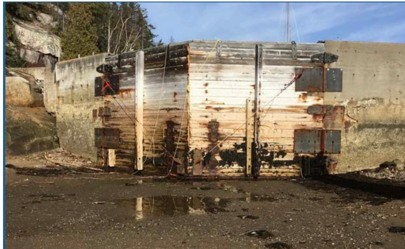
Figure 193 : Vue des portes de la cale sèche, Tadoussac (Source : Tidesoftadoussac.com).
