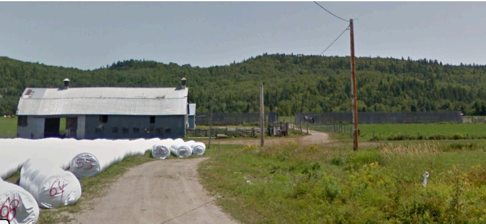
Figure 128 : Grange-étable possiblement ancienne et passablement transformée (date inconnue), 51 rang Saint-Joseph, Sacré-Cœur (Source : Google Maps).
