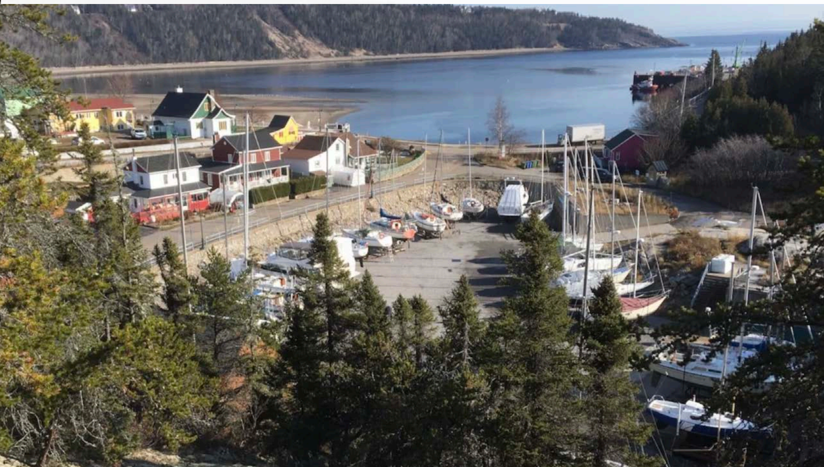
Figure 194 : Vue plus récente de la cale sèche à Tadoussac (Source : Tidesoftadoussac.com).
