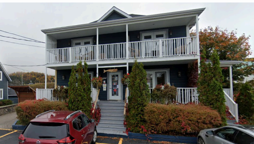
Figure 165 : Vue de l'Hôtel-Motel le Béluga (1930), 187-191 rue des Pionniers, Tadoussac (Source : Google Maps).
