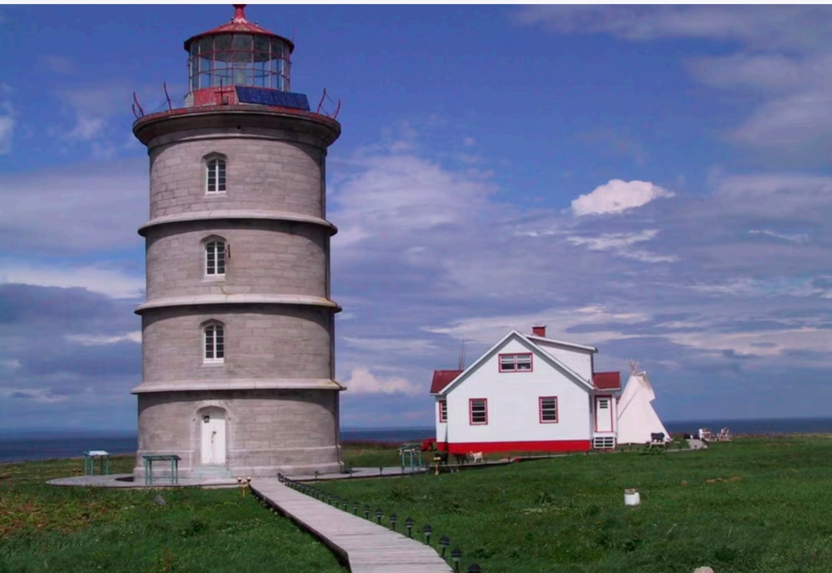
Figure 208 : Vue en 2002 du phare de l'île Rouge (1848) et de la maison du gardien aujourd'hui démolie, Parc marin du Saguenay–Saint-Laurent près de Tadoussac (Source : Journal Le Soleil).
