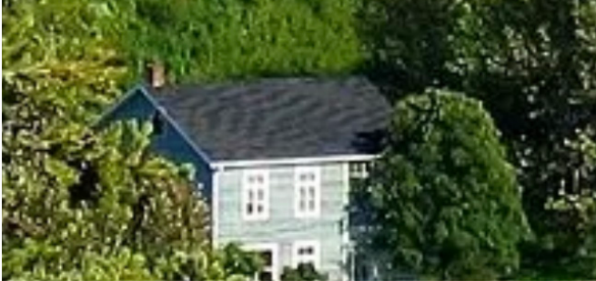
Hôtel, moulin à bois, menuiserie et atelier d'électricité (1930) 47 rue Principale
