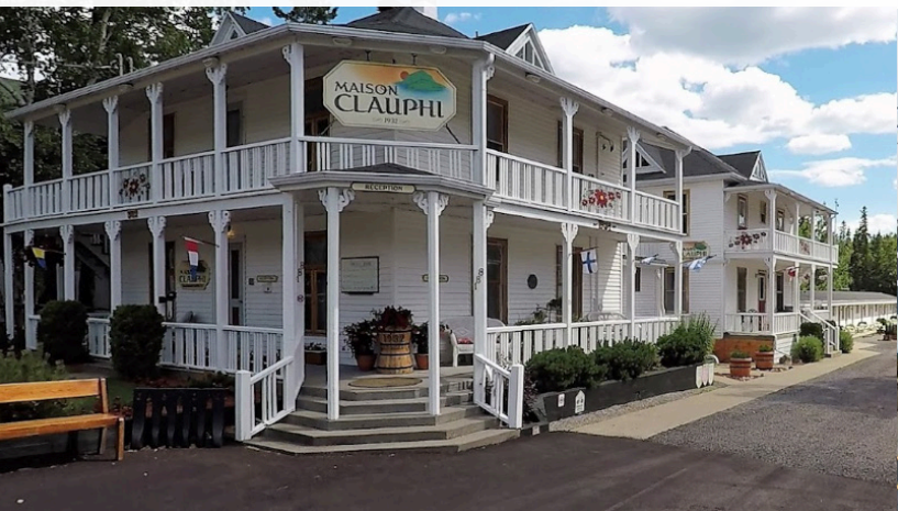
Figure 164 : Vue de la Maison Clauphi (1931), 188 rue des Pionniers, Tadoussac (Source : Google Maps).
