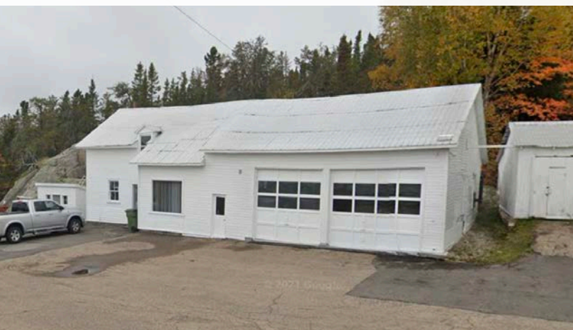
Figure 120 : Ancienne forge (date inconnue) aujourd'hui un bâtiment secondaire, 297 rue des Forgerons, Tadoussac (Source : Google Maps).
