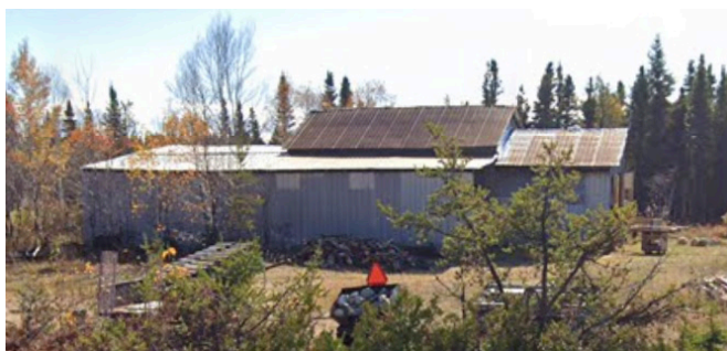
Ancienne école de rang convertie en remise (plusieurs annexes) Sur le site de cette propriété bordant le fleuve, les premiers chercheurs sont venus observer les baleines (s.d.) 294 route 138
