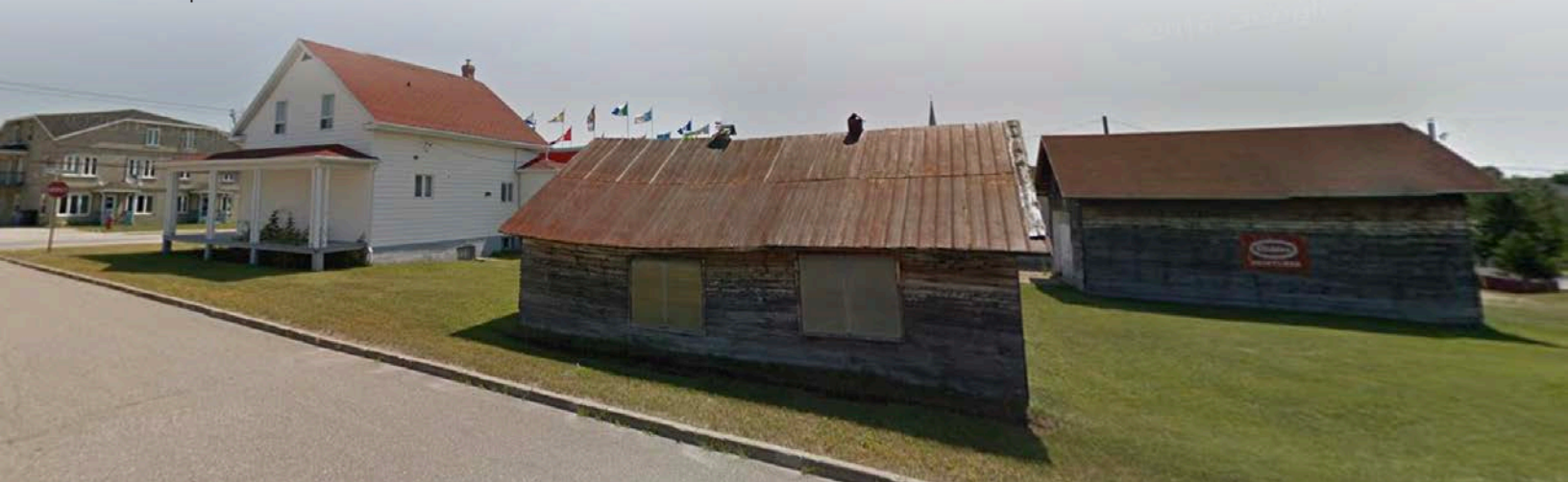
Figure 144 : Remises en cour arrière (date inconnue), 57 rue Saint-Alphonse, Sacré-Cœur (Source : Google Maps).
