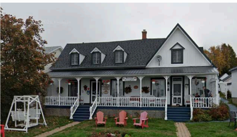
Figure 167 : Vue de l'auberge la Maison Hovington (1865), 285 rue des Pionniers, Tadoussac (Source : Google Maps).
