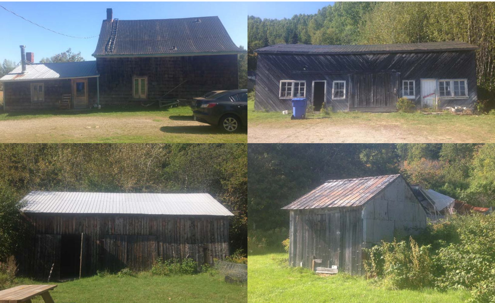
Figures 134 à 137 : Vues de la partie arrière de la maison et des bâtiments agricoles de l'ancienne ferme Hovington (1848), rue des Pionniers, Tadoussac (Source: SARP).
