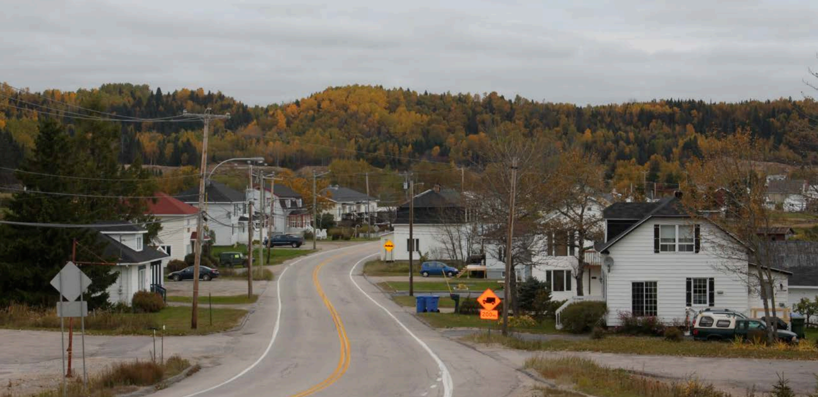
Figure 243 : Vue de la rue Principale dans le secteur Saint-Paul-du-Nord, Longue-Rive (Source : SARP).
