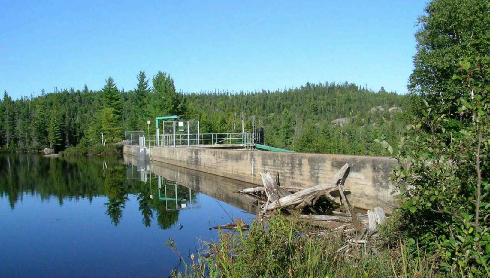
Figure 158 : Vue actuelle du barrage des Petites-Bergeronnes (1954), Les Bergeronnes (Source : Groupe Axor).
