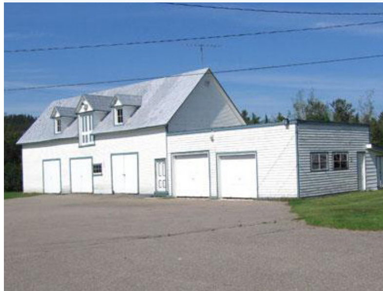
Figure 69 : Garage-remise du curé (1913), 84 rue Principale Nord, Sacré-Cœur (Source : Répertoire du patrimoine culturel du Québec).
