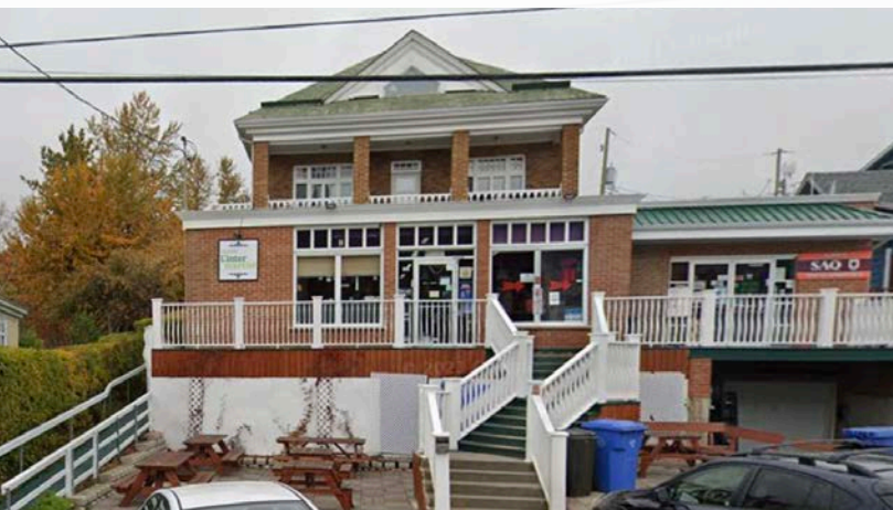
Figure 122 : Ancienne épicerie Côté (1926), 243 rue des Pionniers, Tadoussac (Source : Google Maps).
